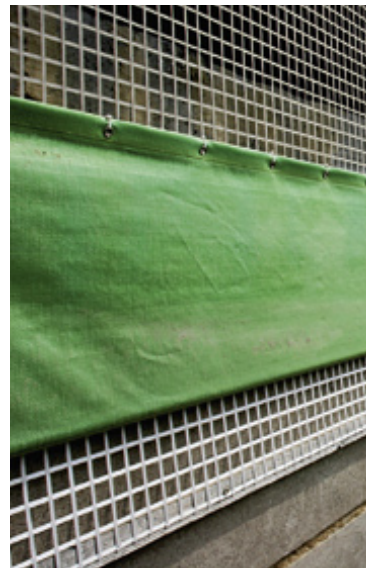
Das Anbringen von Schutznetzen kann Vögel vom Einfliegen in den Stall abhalten. Allerdings müssen die Netze auf die Vogelart abgestimmt werden. Sperlinge passen noch durch Maschenweiten von 40 mm.
